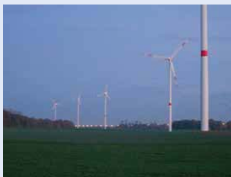
La dérogation délivrée pour ces 5 éoliennes (Perwez, Wallonie, Belgique) inclut la mise en drapeau, car des espèces migratrices de chauves-souris ont été détectées pendant l'étude d'impact. © T. Kervyn
